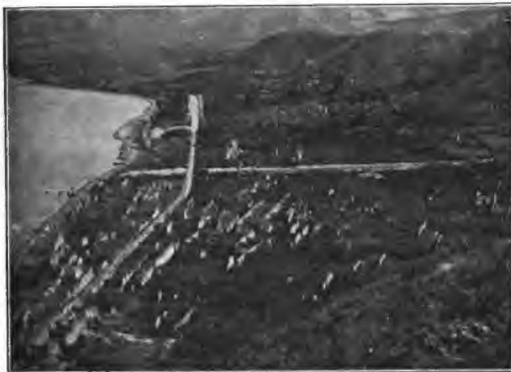
Fig. 262. — La végétation dans les ruines de Saint-Pierre; la rue Victor-Hugo est déblayée. A comparer à la figure 95 [p. 233] (Phot. Leboullanger, avril 1907).
